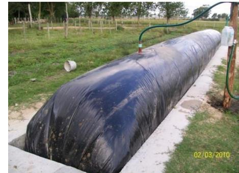
En ejecución la construcción del biodigestor tipo laguna tapada en el municipio matancero de Martí por parte de la empresa mexicana GT Energía Renovable.
